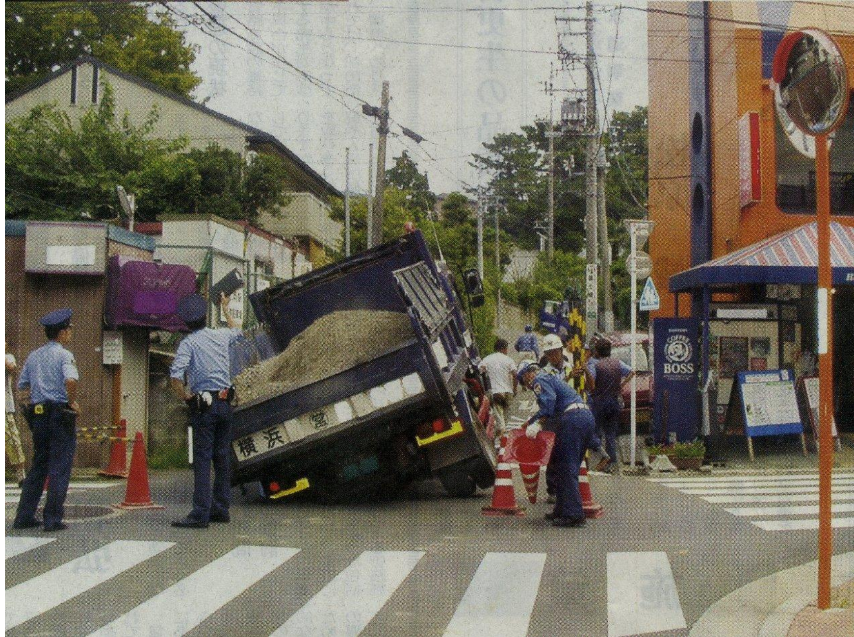
下水道陥没事故
